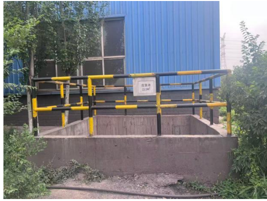
固废（危废）储存库应急池
