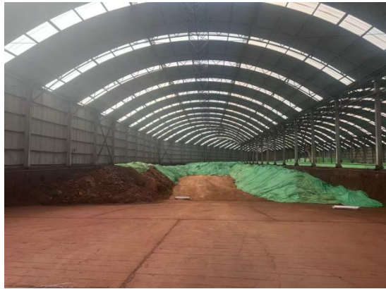
不锈钢除尘灰贮料池内部
