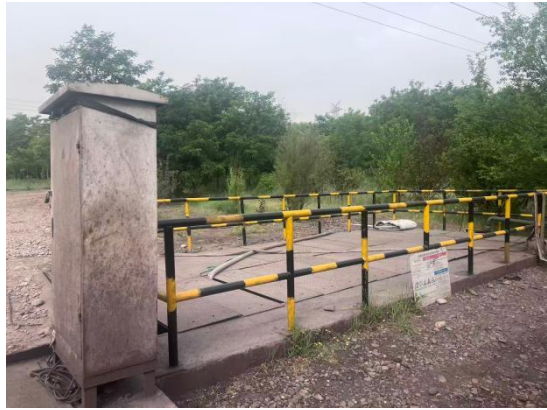
不锈钢除尘灰贮料池洗车废水池
