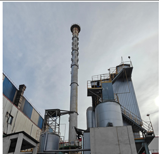
隧道炉脱硫除尘脱硝系统+排气筒
