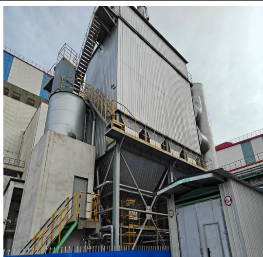
隧道炉脱硫除尘脱硝系统+排气筒
