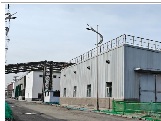
层流冷却循环水泵房（左）+层流过滤器间 （中）+除盐车站（右）
