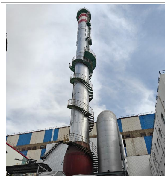
步进式加热炉脱硫除尘系统+排气筒
